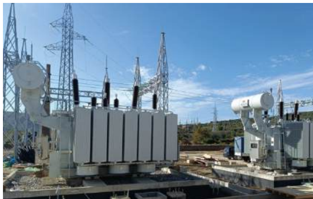
图：阿尔巴尼亚Pier光伏电站项目
