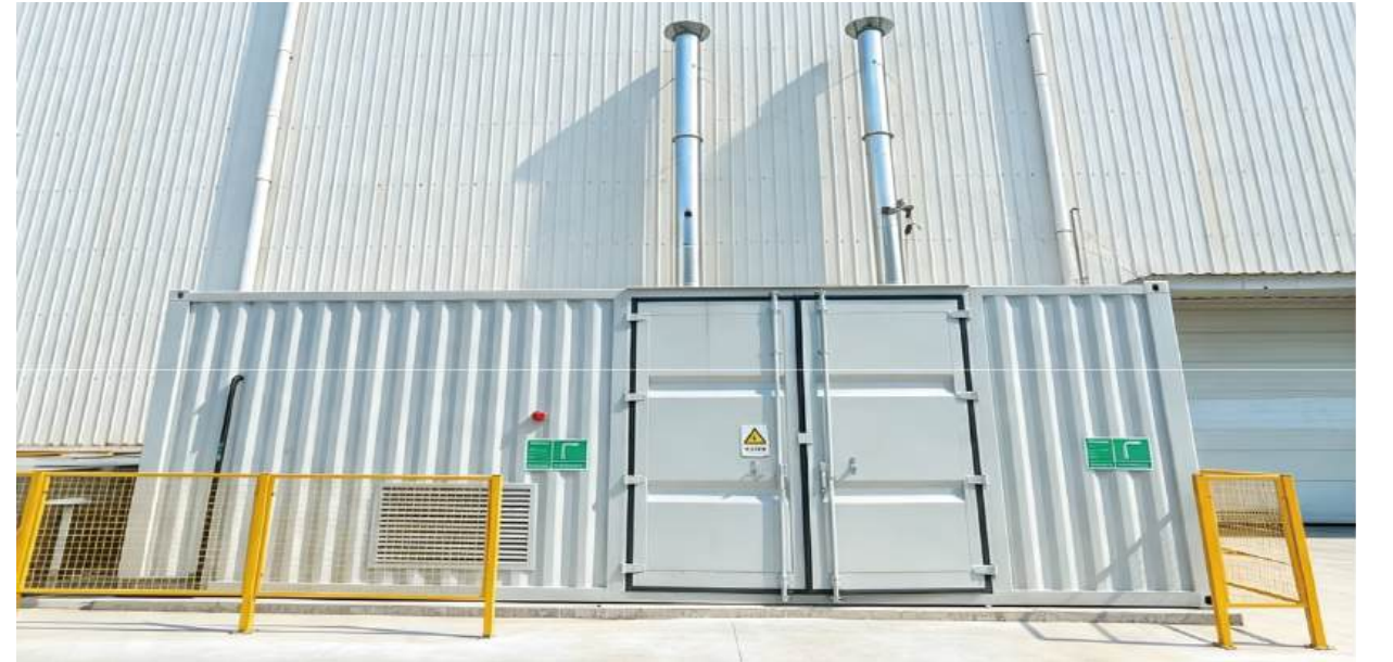
图:蒸汽发生器热水循环技改项目
